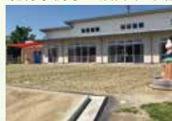
園庭の芝生化工工事
