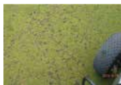
透水管が詰まり、砂土壌にもかかわらず苔が繁茂していた。
