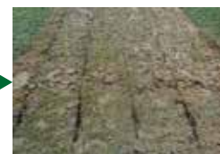
酸素不足の土壌にターフリフレッシャーを施工。
