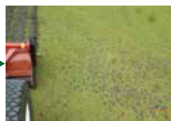
地面にターフリフレッシャーを施工していく。
