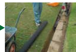
側溝にフラッシングコアを入れて排水を促進。
